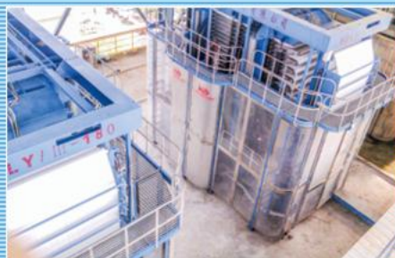
瑞木镍钴管理（中冶）有限公司 （巴布亚新几内亚）（湿法镍钴冶炼） Ramu NiCoManagement (MCC) Limited (Papua New Guinea) (Ni-Co Hydrometallurgy)
